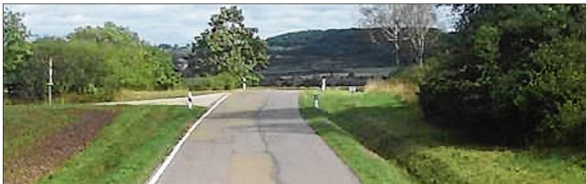
Die Kreisstraße AN 20 zwischen Bauzenweiler und Auerbach wird demnächst saniert.
