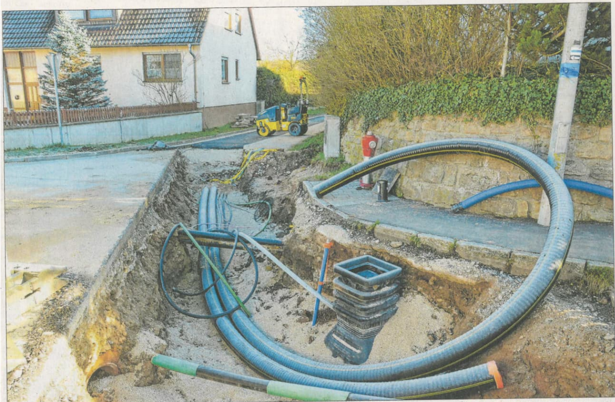
In Geilsheim wurde bereits kräftig gegraben. Die Erschließungsarbeiten zur Nahwärme-Versorgung werden auch dazu genutzt, das Glasfasernetz im Ort auszubauen. Foto: Peter Tippl
