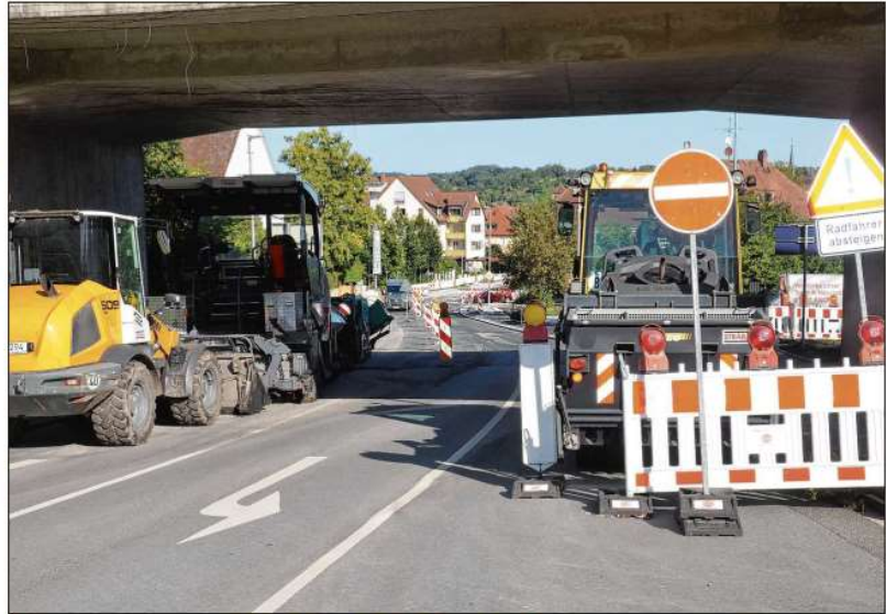
Hier, am oberen Ende der Ansbacher Straße, kurz vor der Einmündung in die Comeniusstraße, steht die Armada der Teer- und Asphaltierungsmaschinen schon bereit. Foto: Patrick Lauer
