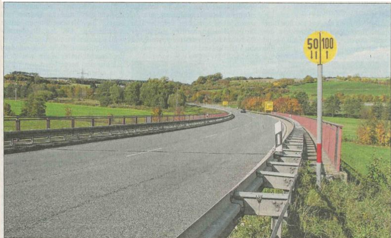
Die Aurachtalbrücke der B8 wird saniert.
