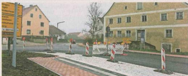
Auch der zweite Bauabschnitt ist fertiggestellt. Nun geht die Baustelle an der Ortsdurchfahrt Gnotzheim erst einmal in die Winterpause. Foto: Werner Höchstetter
