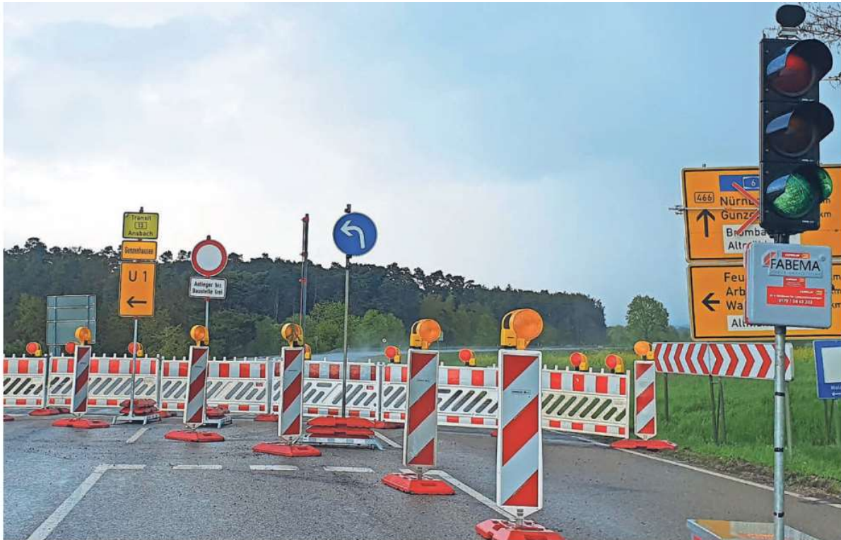
Blick auf die gesperrte B 466 bei der Gärtnerei Kuck in Richtung Gunzenhausen: Dieser erste Bauabschnitt ist fertig, nun zieht die Baustelle weiter.
