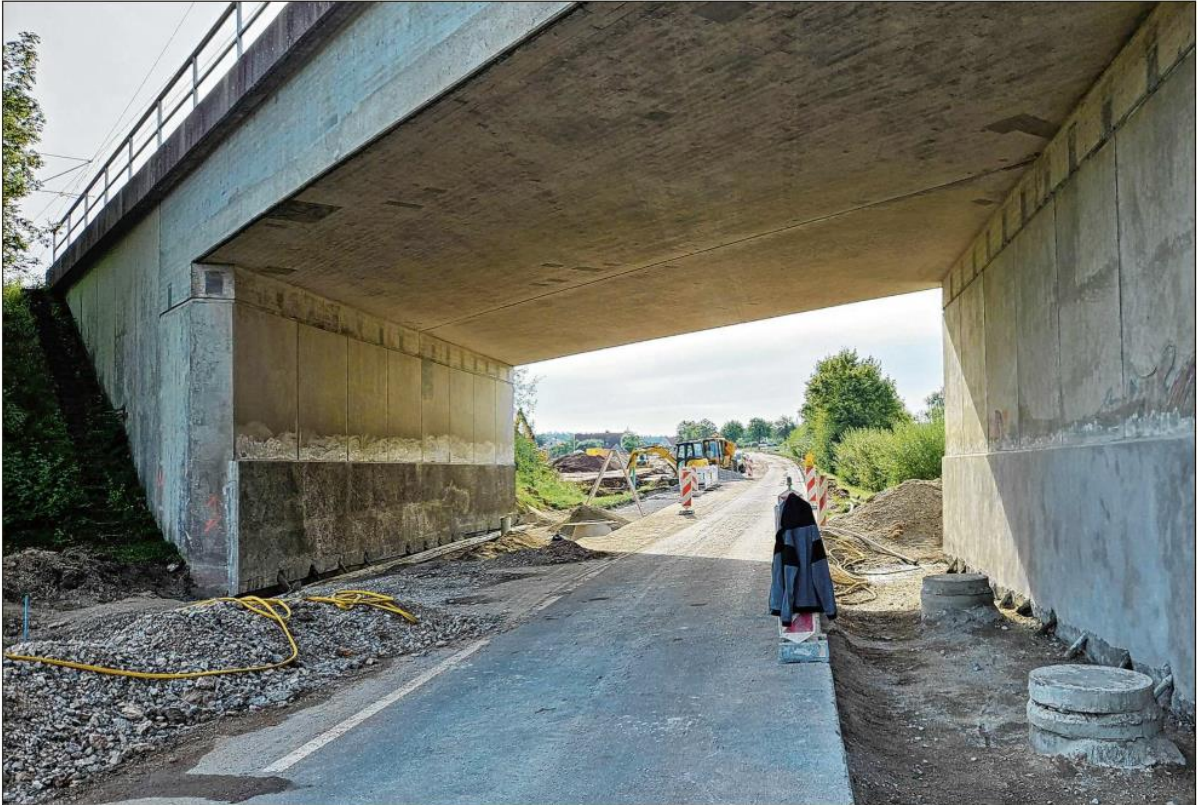
Was das Staatliche Bauamt zunächst nicht für möglich hielt, wird nun doch möglich gemacht: Der Radweg an der Staatsstraße 2246 wird mit unter die Bahnunterführung bei Wiedersbach gelegt. Foto: Wolfgang Grebenhof
