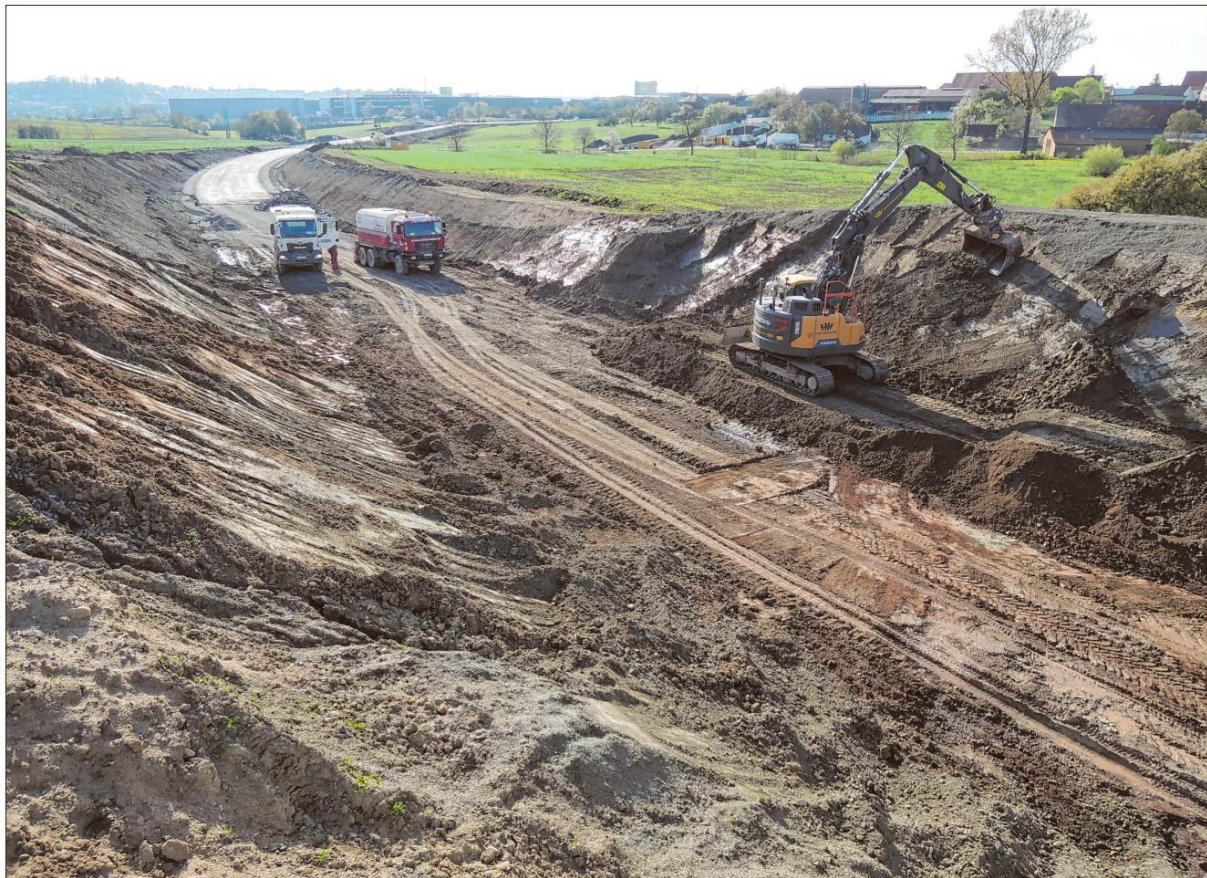
Der Blick von der neuen Brücke auf den östlichen Abschnitt der künftigen Umgehungsstraße bei Sommerau. Bis kurz vor dem Kreisverkehr der Staatsstraße 1066 mit der Daimlerstraße ist auf der Trasse bereits die Asphalttragschicht aufgebracht. Foto: Peter Zumach
