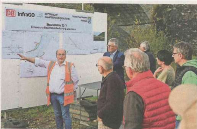
Andreas-Thomas Fechner, Baudirektor des Staatlichen Bauamts Ansbach, erläuterte den Anwesenden detailliert mithilfe der Pläne, wie Brücke und Straße künftig verlaufen sollen.
